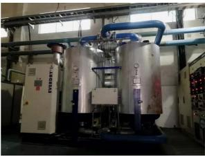
客户对于压缩空气的品质要求是仪表用压缩空气的压力露点优于-40℃,含尘等级优于0.1um, 含油量优于0.01mg/m³。
