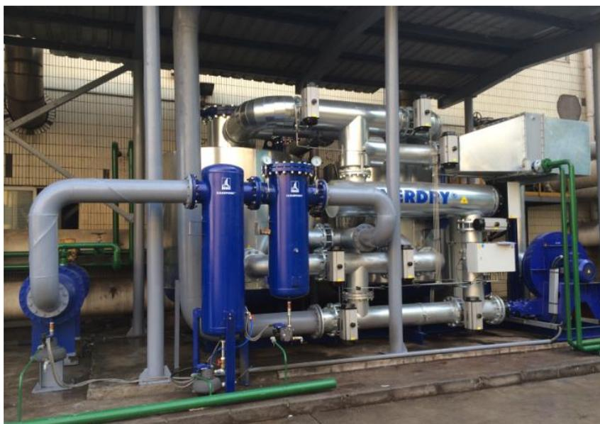
为了改善压缩空气品质，节能降耗。兴澄特钢对三期空压站进行了节能改造。用贝克欧的4台FRL-15000C零损耗鼓风加热再生吸附式干燥机取代了原来的5台微热吸干机，压缩空气品质得到了明显的改善，压缩
