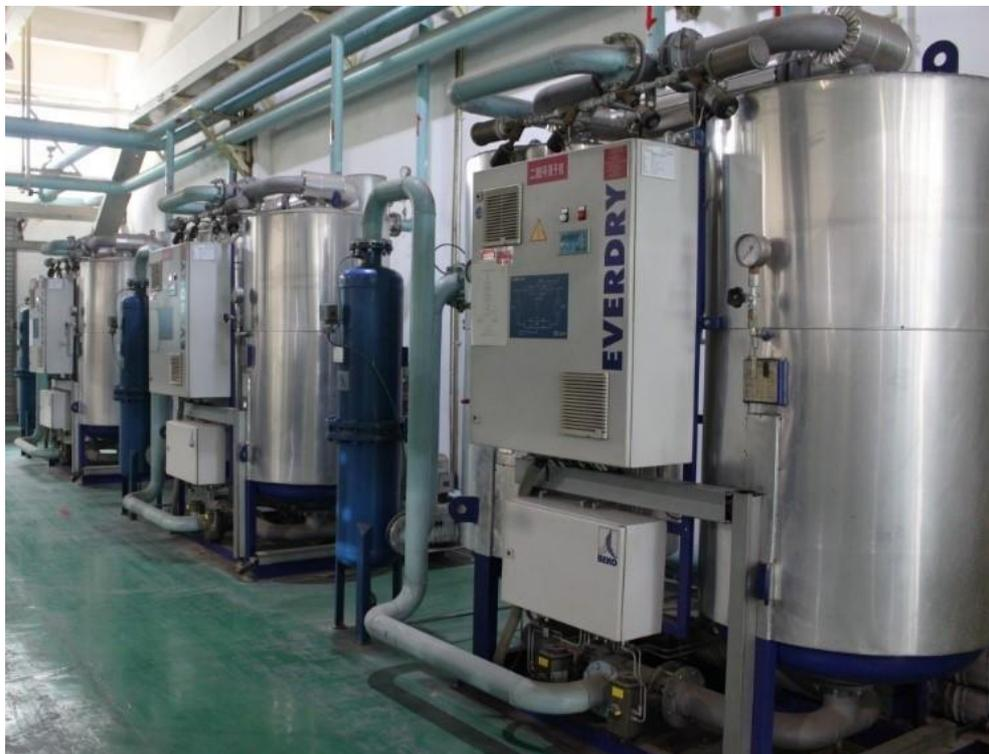
为了改善压缩空气品质，节能降耗。客户对于一期空压站进行了节能改造，换上了贝克欧公司生产的3台EVERDRY FRP-2900C鼓风加热再生吸附式干燥
