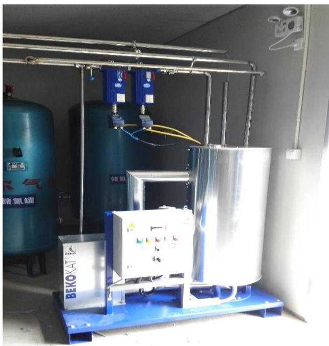
压机后端加装无油催化机 (BEKOKAT) 进行压缩空气无油处理, 按这样的配置方式, 无需再重复投资购买无油空压机, 也不会造成现有空压机的闲置浪费, 更重要的是: 无论是空压机本身润滑产生的油还是空压站环境空气中含有的油, 无油催化机 (BEKOKAT) 都能进行彻底的处理, 进而获得比无油空压机更高品质的无油压缩空气, 能很好的满足生产现场对压缩空气的高质量要求, 并且客户在压缩空气使用中如果含油量超标会影响
