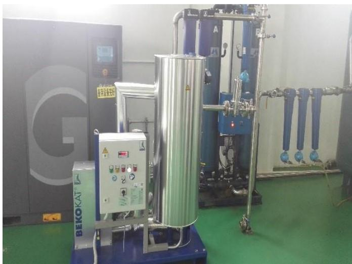
BEKO公司催化技术取得了新的成果，确立了压缩空气净化技术的新标准，把残油含量控制在 $\leq 0.003 \text{ mg/m}^3$ 。BEKOKAT 让这一技术成为现实，并且拥有很高的可靠性和极佳的实用性。
